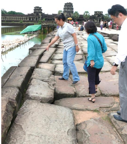
今回修復対象となる西参道の様子。
